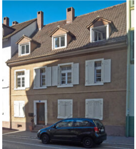
Lorettostraße 14. Trotz historischem Wert 2018 abgerissen (Foto: K. U. Müller).
