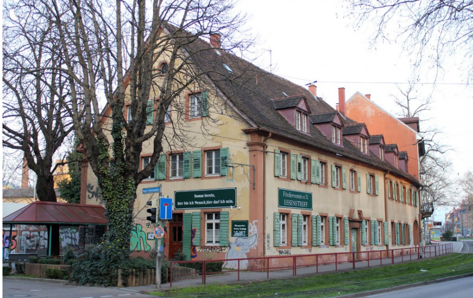
Ignoranz: Das denkmalgeschützte „Dreikönigshaus“ will die Stadtverwaltung ggf. abreißen, um an der Stelle Baumaterial für die Baustelle des Stadttunnels lagern zu können. (Foto: M. Managò)
