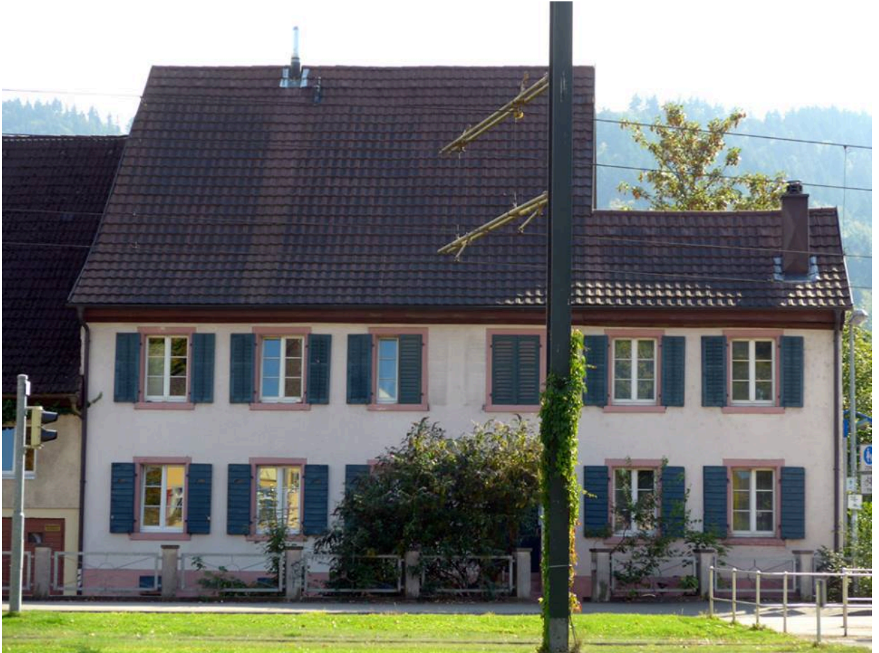
Das zum Abbruch vorgesehene Haus Schwarzwaldstraße 36 (Foto: J. Scheck)
