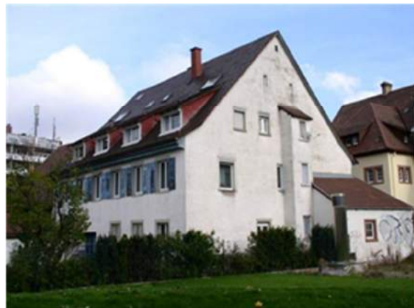
Haus 40 von Nordwesten: Wohnteil mit Abtrittkerker. (Fotos auf dieser Seite: Scheck)
