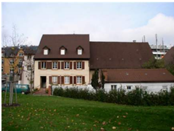
Häuser Nr. 36 (links) und 38 (rechts, ehem. Ökonomiebau mit vorgelagertem Schuppen) von Süden
