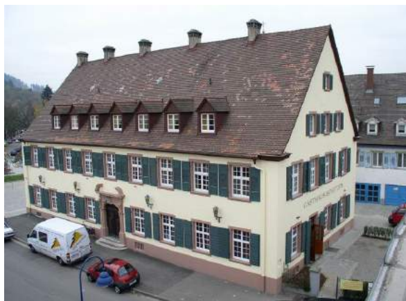
Haus 40 von Nordwesten: Wohnhaus mit Abritterker. (Foto: Urheber unbekannt)
