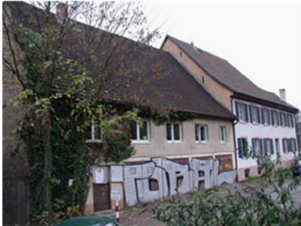
Haus Nr. 38 (links) und 36, Nordfassade (Schwarzwaldstraße, Zustand 2004)
