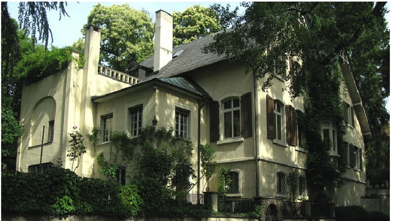
Das Kulturdenkmal „Reinhold-Schneider-Haus“ in der Mercystraße im Stadtteil Wiehre ist bedroht durch einen modernen, kastenförmigen Anbau und zwei geplante Neubauten im ausdrücklich ebenfalls denkmalgeschützten Park.
