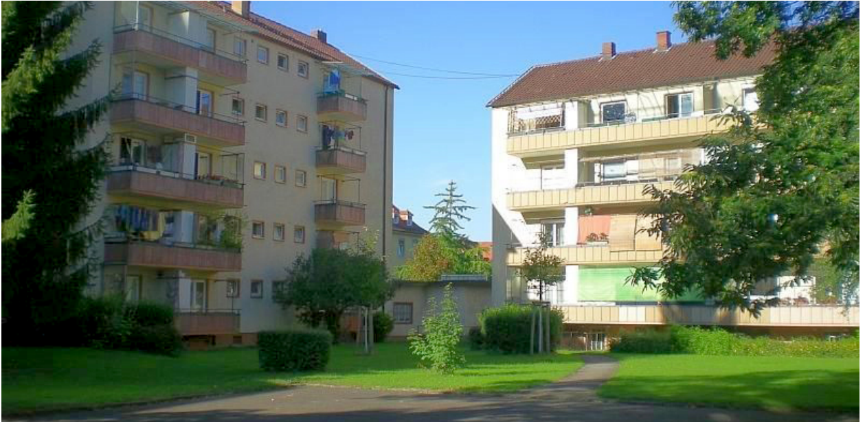
Der Abriss von Altbauten vernichtet bezahlbaren Wohnraum zugunsten von teurerem Neubau. Hier der Innenhof eines der Gebäudekomplexe im Klinikviertel (Foto: N. Armbruster)
