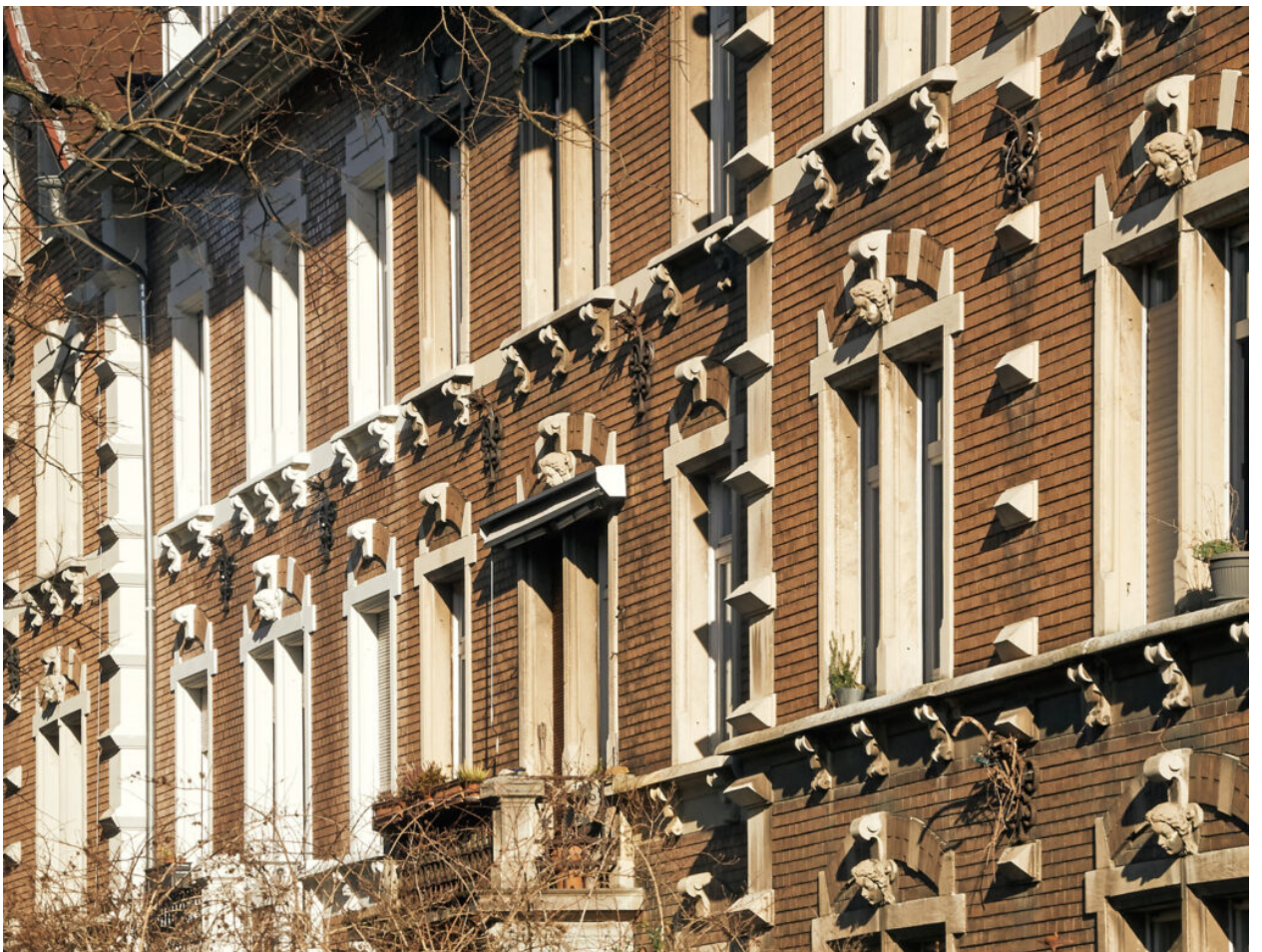
Detailreiche und wohlgestaltete Fassade in der Turnseestraße (Foto: K. U. Müller).
