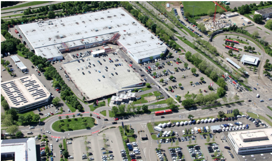
Großflächiger, einstöckiger Flächenverbrauch in Gewerbegebieten (Foto: W.-D. Winkler)
