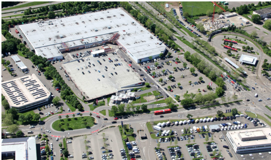
Großflächiger, einstöckiger Flächenverbrauch in Gewerbegebieten (Foto: W.-D. Winkler)
