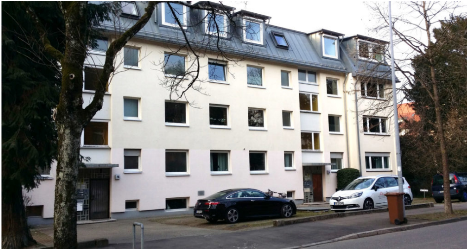
Das Mehrfamilienhaus Stadtstraße 16/16a mit den Parkplätzen vor dem Haus (Foto: M. Managò)
