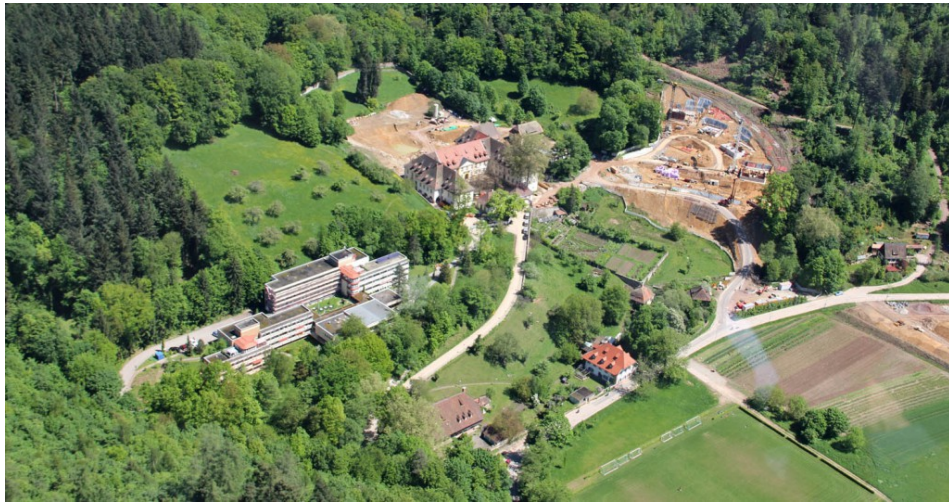
Das Areal des Kartäuserklosters in Freiburg: Unten in der Mitte der Meierhof, links oberhalb das Seniorenheim aus den 70er Jahren, in der Mitte oberhalb das alte Kloster und rechts neben dem Kloster die Baustellen für die Betonwürfel des UWC (Foto vom 18.05.2014; Dr. W.-D. Winkler)
