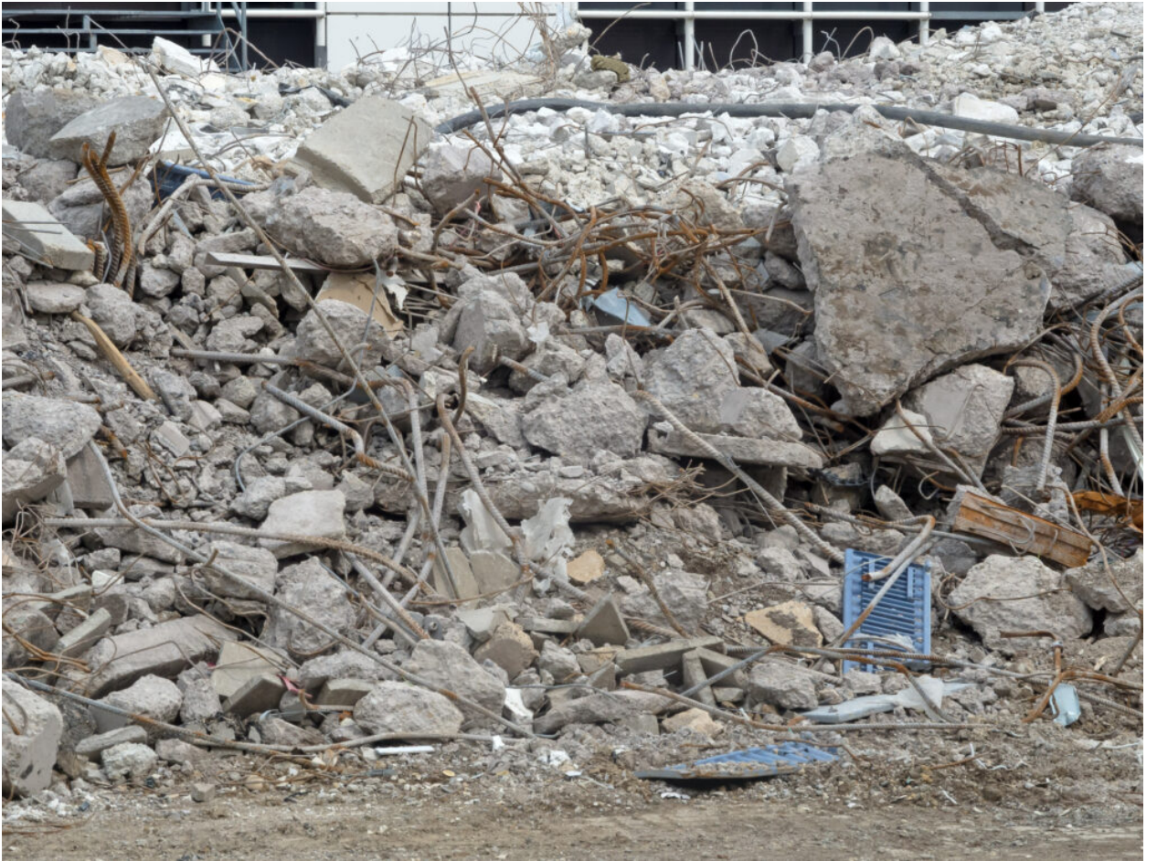
Enorm viel Abbruchabfall fällt bei den zahlreichen Gebäudeabrissen an (Foto: K. U. Müller).
