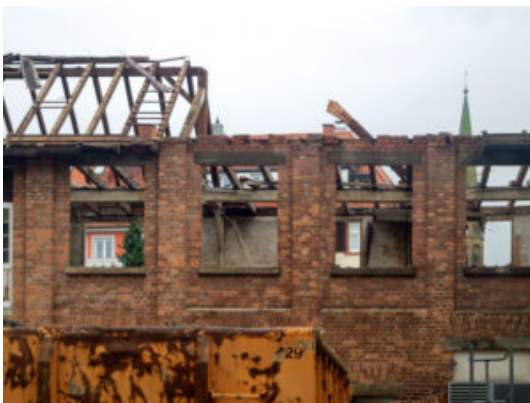
Abrisse alter liebenswerter Häuser in der Wiehre in einem Fort (Foto: K. U. Müller)
