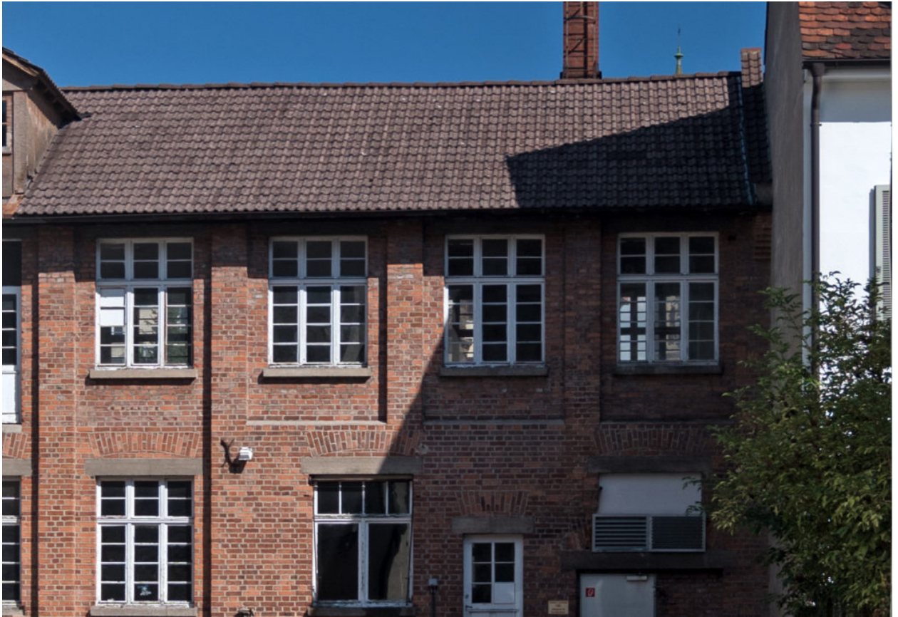
2017 begann mit dem Abriss dieser schönen alten Fabrik eine Baustellenserie in der Kirchstraße, die bis heute andauert (Foto: K. U. Müller)
