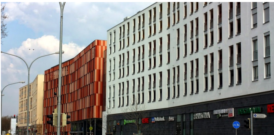
Ein Monstrum in Beton für Investoren aus aller Welt: Die Westarkaden (Foto: U. Glaubitz)
