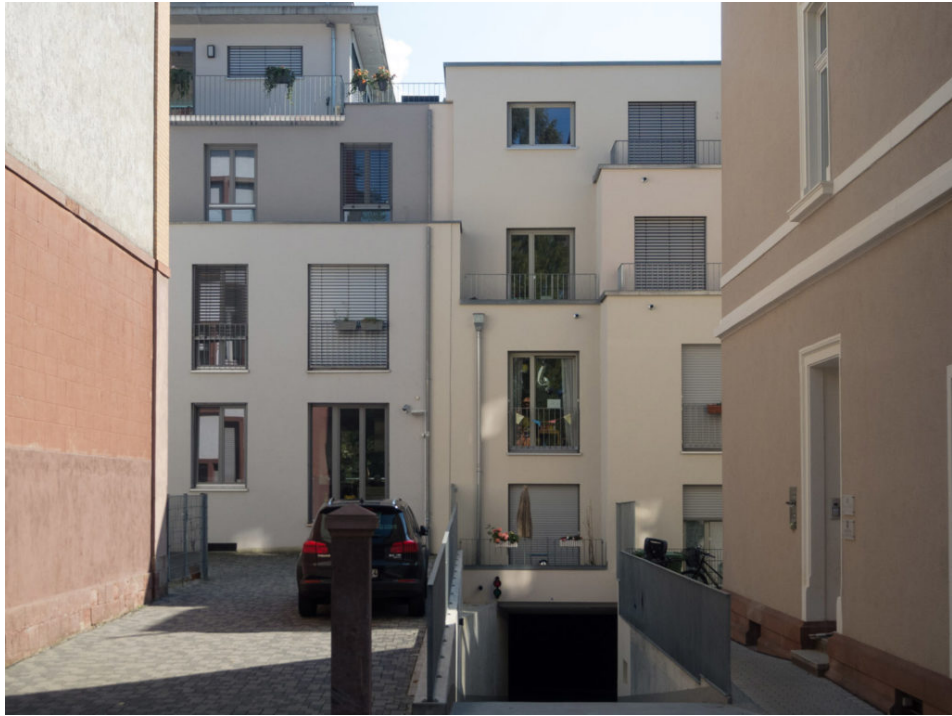
Austauschbare Baukisten, hier z.B. in der Baslerstraße (Foto: K. U. Müller)
