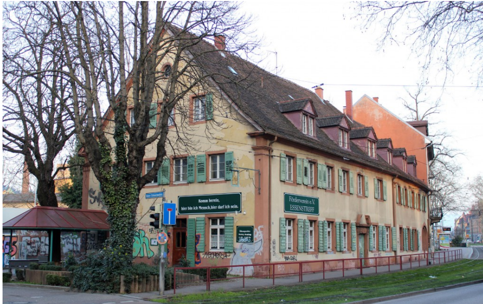
Das denkmalgeschützte "Dreikönigshaus" will die Stadtverwaltung nach wie vor abreißen, um eines Tages vielleicht dem Stadttunnel Platz zu machen (Foto: M. Managò).
