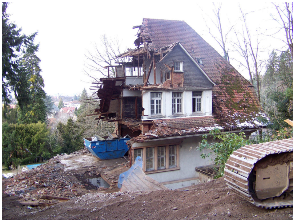
Das Haus in der Wintererstraße 28 stand unter Denkmalschutz, wurde aber dennoch mit fadenscheinigen Beründungen abgerissen!
