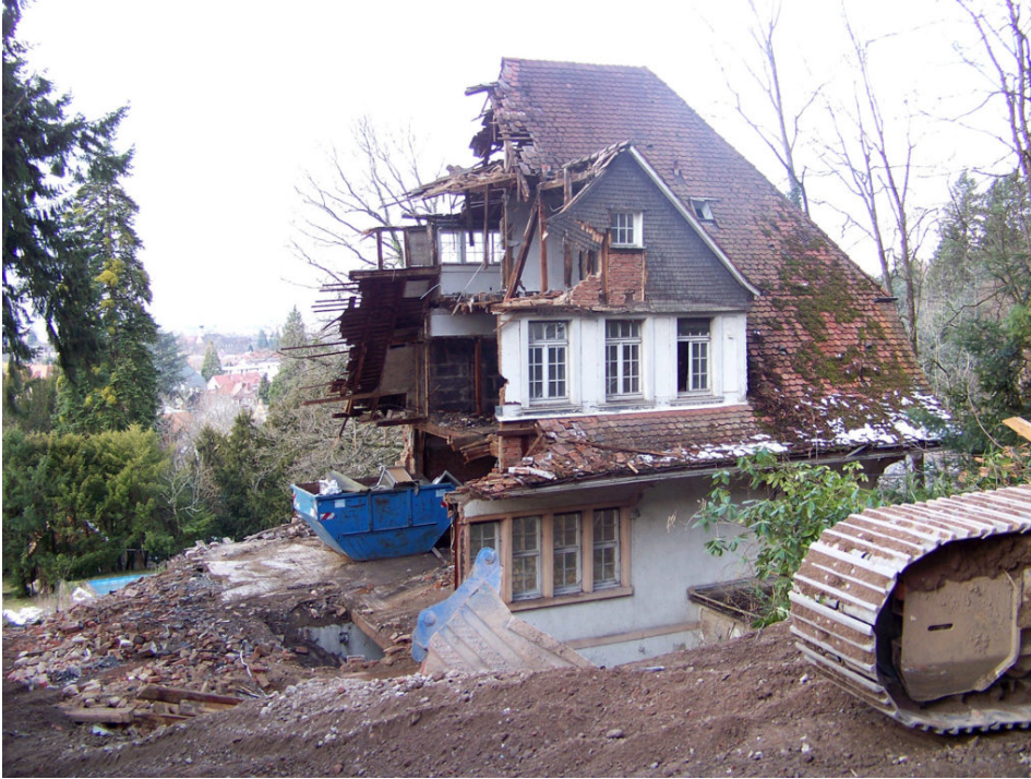
Das Haus in der Wintererstraße 28 stand unter Denkmalschutz, wurde aber dennoch mit fadenscheinigen Beründigungen abgerissen!
