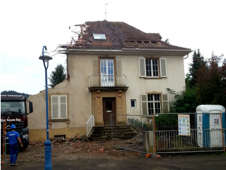
Abriss der Villa in der Siberbachstr. 25 (Foto: G. Zimmer)
