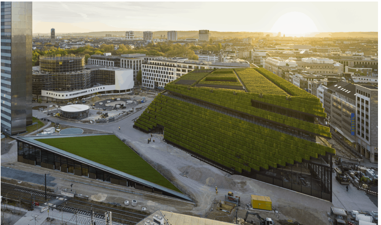
Komplett mit Haimbuche-Hecken bepflanztes Gebäude in Düsseldorf, Archtekenbüro: Ingenhoven Architects (Foto: HG Esch)
