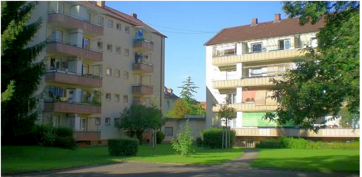
Innenhof eines der Gebäudekomplexe im Klinikviertel die abgerissen und durch teure Neubauten ersetzt werden sollen (Foto: N. Armbruster)
