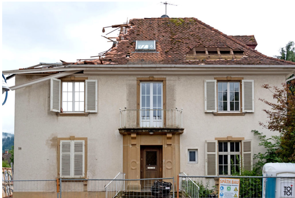
Abriss der Villa in der Silberbachstr. 25 (Foto: K.-U. Müller)
