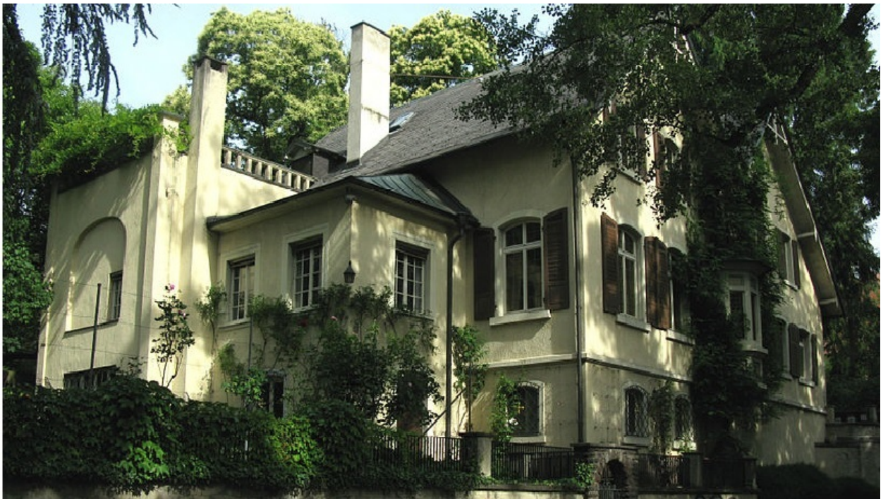
Das Kulturdenkmal "Reinhold-Schneider-Haus" in der Mercystraße im Stadtteil Wiehre.
