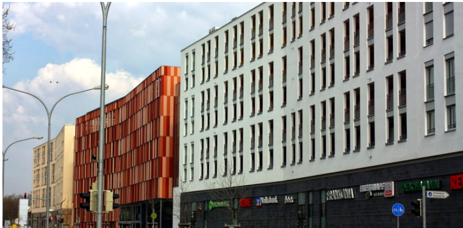
Ein Monstrom in Beton für Investoren aus aller Welt: Die Westarkaden
