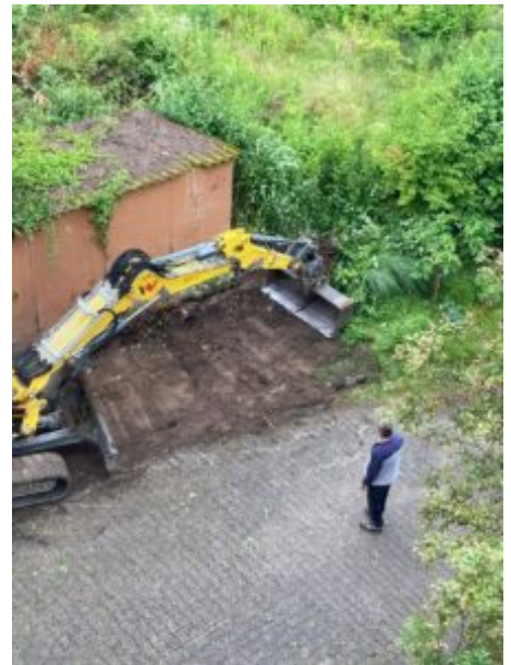
Der Bagger parkt auf dem Nachbargrundstück (Foto: P. Vogt).
