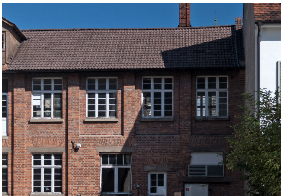
Kirchstraße 9a im Jahr 2015 vor dem Abriss (Foto: K. U. Müller)
