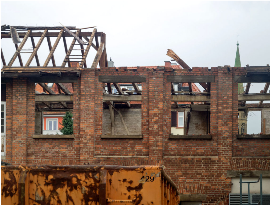
Abriss der KIRSTstraße 9a im August 2017 (Foto: K. U. Müller)
