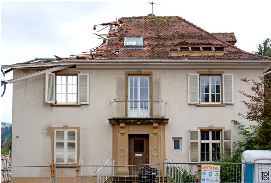
Abriss der Villa in der Siberbachstr. 25 (Foto: K.-U. Müller)
