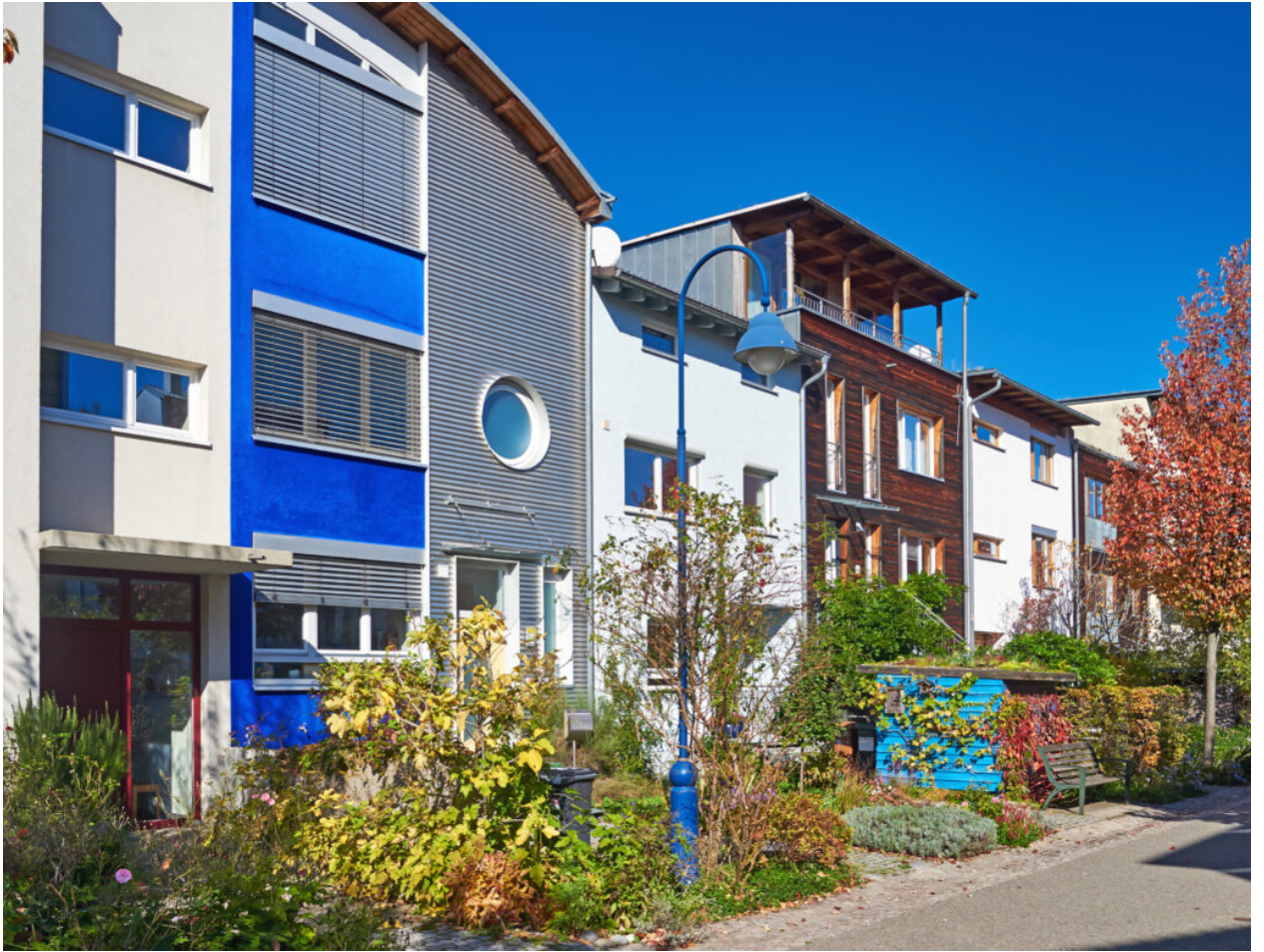
Ganz anders Vauban. Nicht von Bauträgern geplant. So kann Städtebau gehen. Wenn man nur will (Foto: K. U. Müller)
